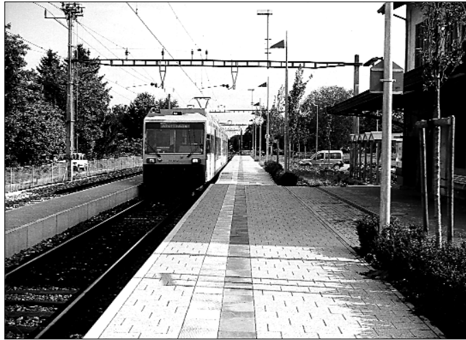
Ausgebauter Bahnhof der Mittelthurgaubahn (Uttwil) mit bequemen Perrons. (Foto Marlies Stopper)
